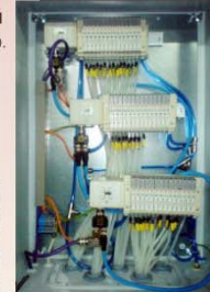
Блоки распределителей SV управляют клапанами молочного агрегата на молочном комбинате
